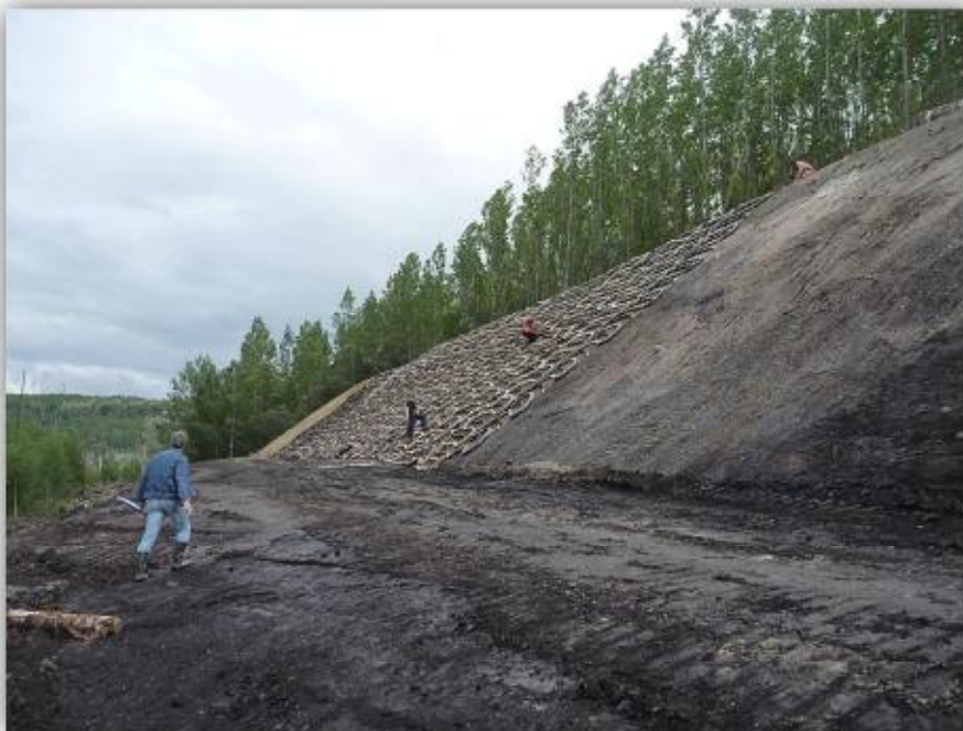
Aufbringen des Geogitters und Befüllung mit Kulturboden (ockerfarbenes Material im Hintergrund), Foto: TLBA
