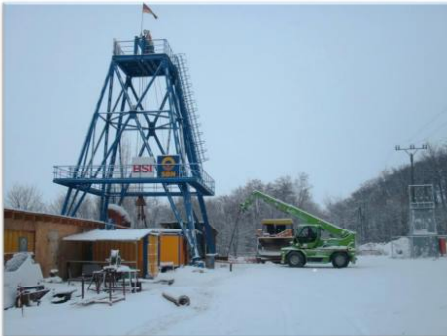
Rückbau der Versturzleitung aus dem Schacht.
