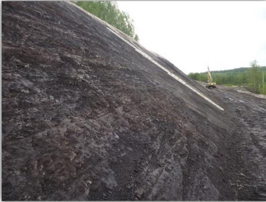
Profilierte Kohleböschung im Restloch Zechau , Foto: TLBA
