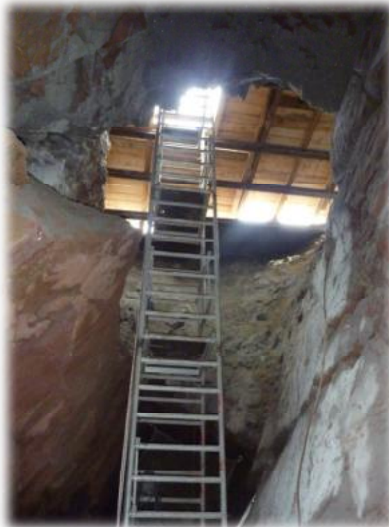
Erkundung von tagesnahem Eisenerzgangabbau der Grube „Neue Hoffnung“ bei Schleiz
