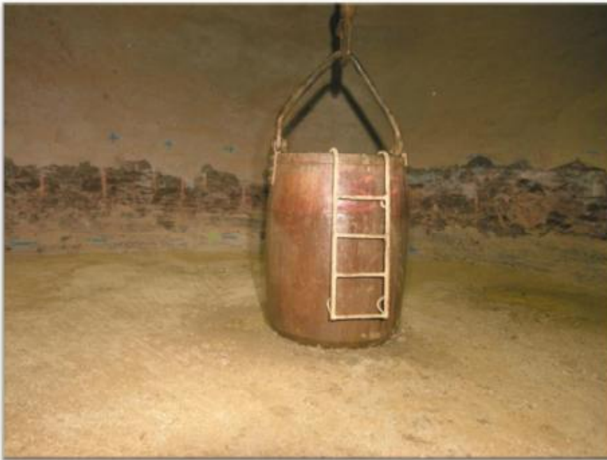
Abschluss der eingebauten Tondichtung bei 598m Teufe.
