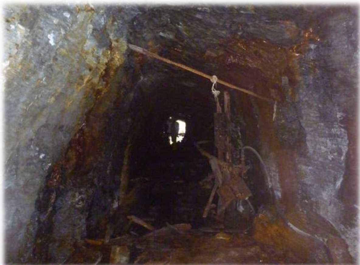
Verwahrung von Tagesöffnungen des Dachschieferbergbaues im Staatsbruch Lehesten
